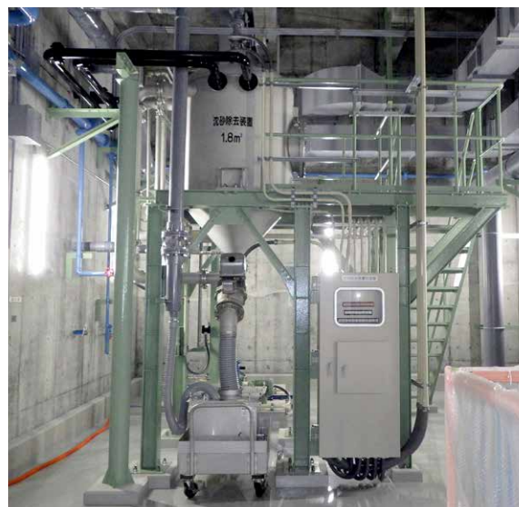
し尿処理場の受入棟
