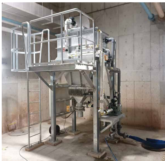
下水処理場の沈砂池棟
